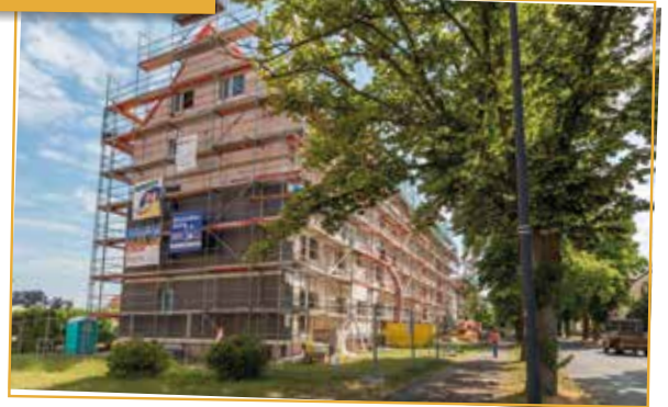
Im Frühjahr wurden alle Mauersägearbeiten durchgeführt, Fenster ausgetauscht, das Gebäude gedämmt und das Dach neu eingedeckt.
