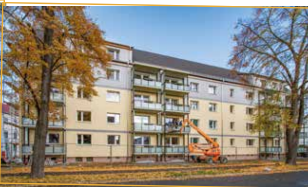
Im Frühjahr wurden alle Mauersägearbeiten durchgeführt, Fenster ausgetauscht, das Gebäude gedämmt und das Dach neu eingedeckt.
